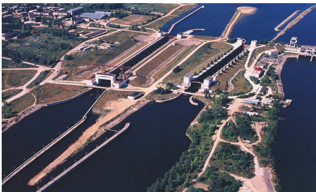
Рис. 3 Шекснинский гидроузел с двухниточными шлюзами
